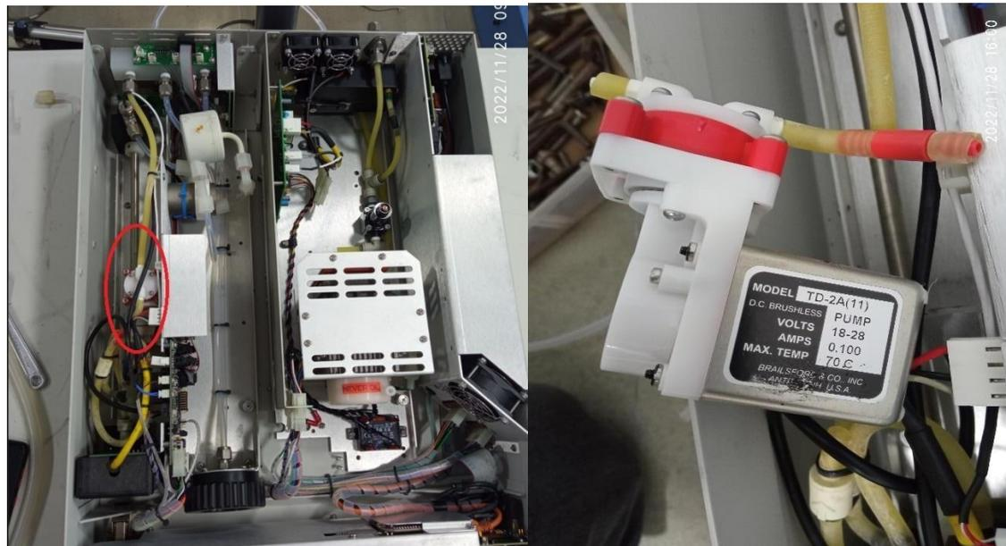
*Ilustración 102. Reemplazo de la bomba de succión y/o del kit de reconstrucción.*
